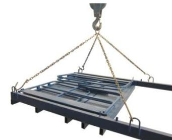
1. Se elevará la plataforma mediante un equipo de elevación (grúa) suficientemente capaz hasta la altura donde ha de instalarse la plataforma. Para ello se utilizará una eslinga de 4 ramales con ganchos de seguridad. Estos ganchos se utilizarán en los 4 amarres situados en ambos lados de la plataforma.
